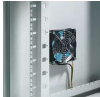
Die passive Klimatisierung erfolgt über Ausbrüche in den Seiten. Für die aktive Klimatisierung können Lüfter optional eingebaut werden.
