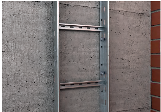
Direkte Montage der Steigleiter an der Massivwand
