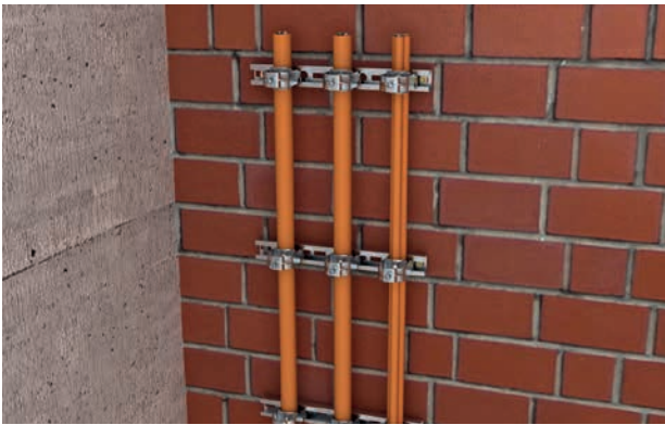
Senkrechte Montage der Kabel mit Bügelschellen an der Wand.
