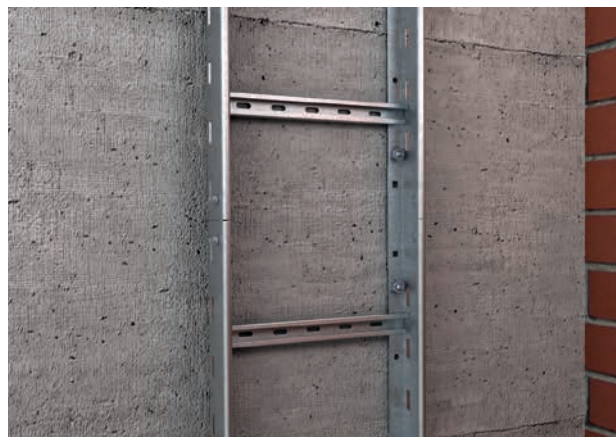
Direkte Montage der Steigleiter an der Massivwand
