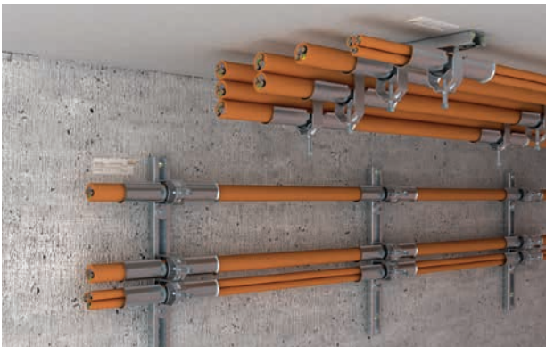
Waagrechte Montage mit Bügelschellen und Langwannen an der Wand und unter der Decke.
