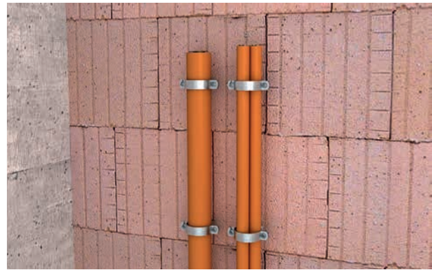
Senkrechte Kabelinstallation als Einzel- und Bündelverlegung an der Wand.
